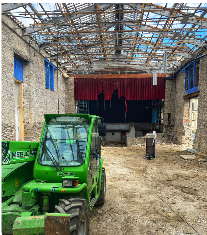
Gros oeuvre - août 2020
